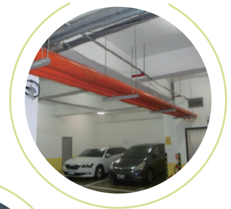
大樓污水管與污水下水道連結
