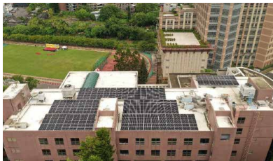
太陽光電發電設備(外雙溪校區)
