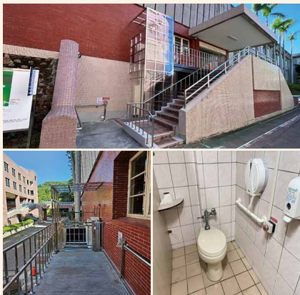
增設無障礙設施
