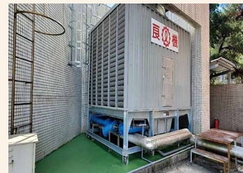
更新水塔設備
